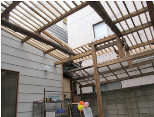
パティオに改修した空間
